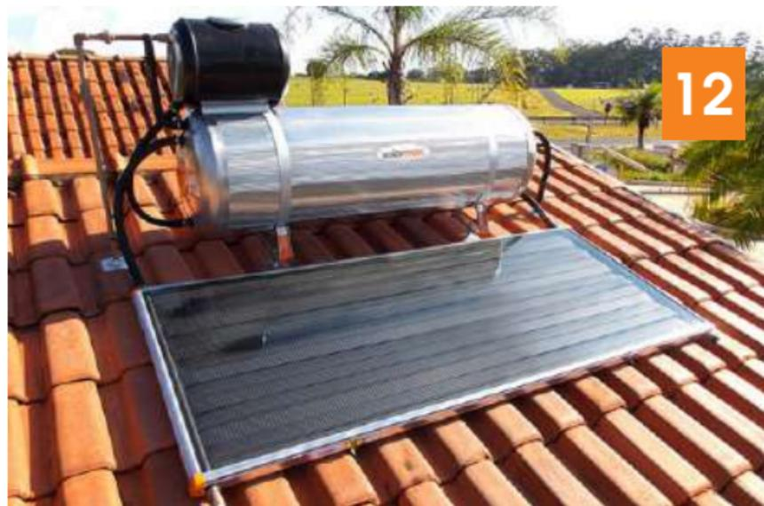
Visão geral do **Aquecedor Solar Solarmax Eco 200** instalado sobre o telhado.
